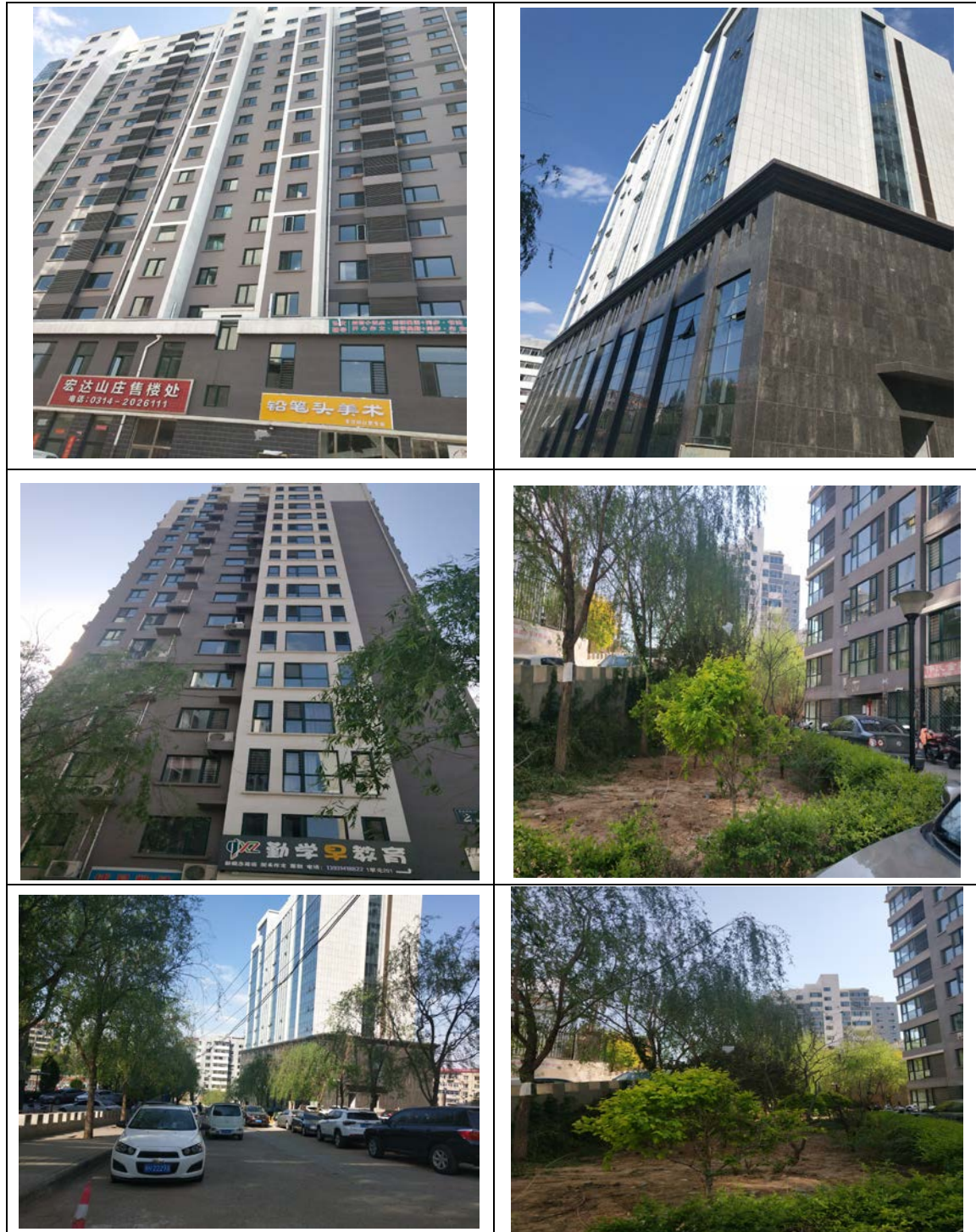
图 1 本项目工程现状照片
